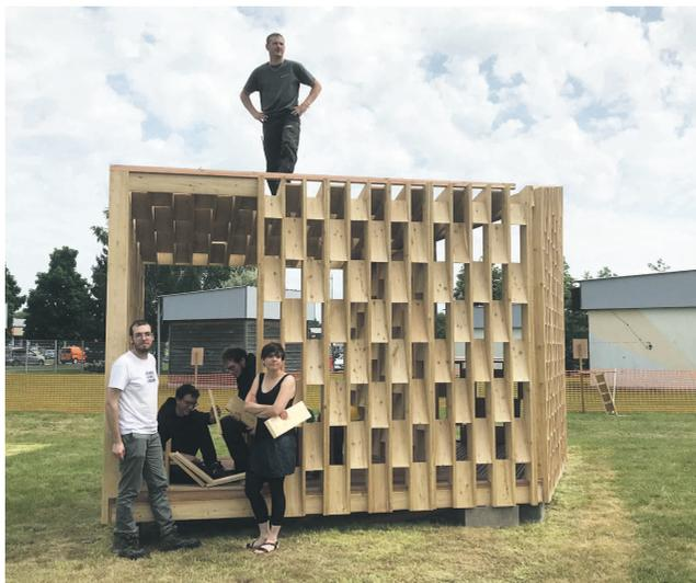
**Prix de l'efficacité poétique et de Séquence Bois** : **Au bord de l'étang - équipe I**. Avec sa couverture faite d'écailles de bois, ce pavillon nomade et facilement manutentionnable joue les pontons d'observation au bord de l'eau.
