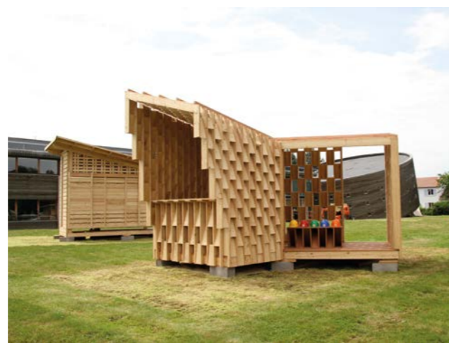
▲ « Au bord de l'étang », prix de l'efficiace poétique et prix Séquences Bois. La rédaction a loué l'ingéniosité et l'élégance de son système de clavettes, employé à la fois pour la structure, le cadrage des vues et la circulation de l'air à l'intérieur du pavillon.
