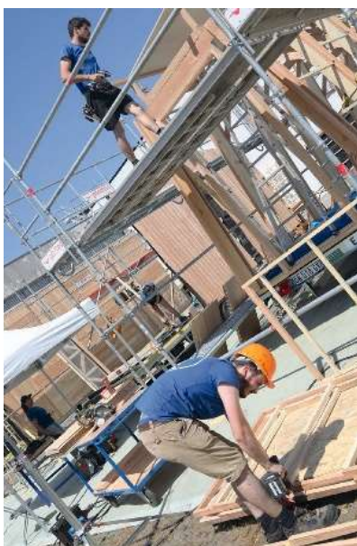
Les micro-architectures 2023, portées par des châssis roulants, ne doivent pas dépasser 3,5 t, principale contrainte avec celle de l'étanchéité...
