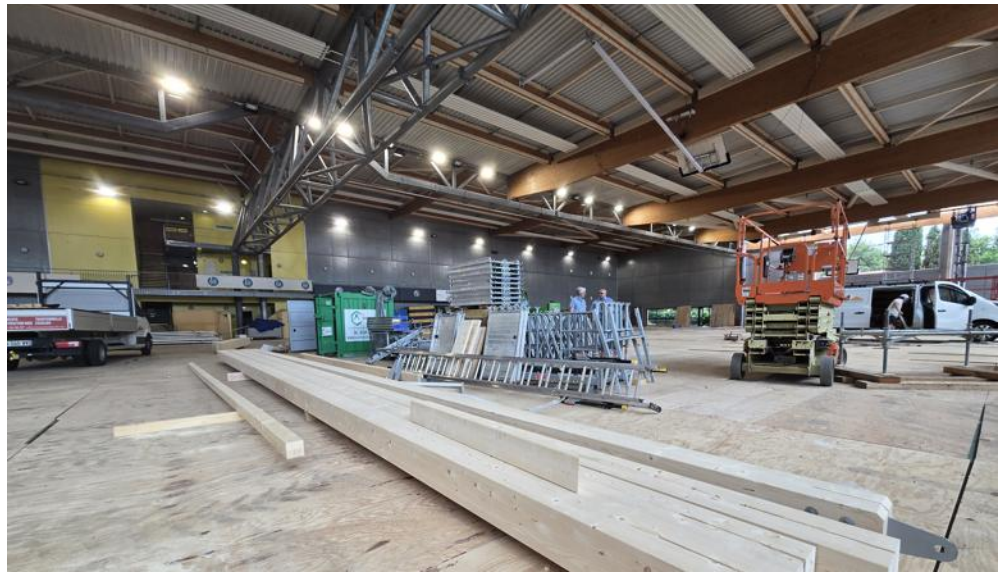
La poutre qui s'était effondrée a été remplacée. Mais l'ensemble des traverses a été renforcé avec des éléments en bois massif. Photo Grégoire Hallinger
